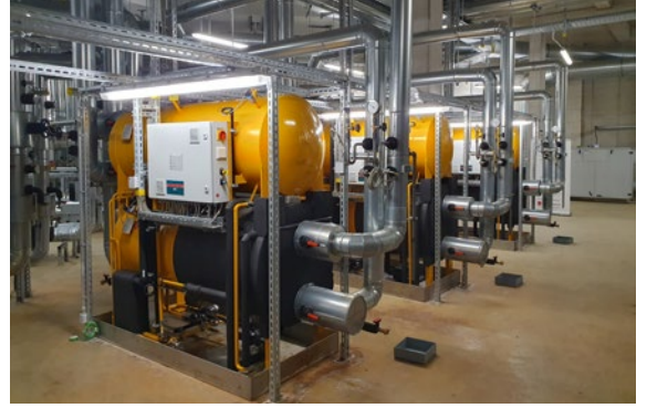
Absorptionskälteanlagen, Kältezentrale Synus-Gebäude.
