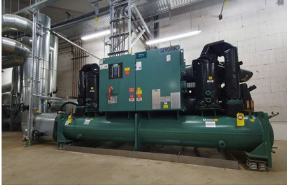
Kompressions- kälteanlage, Kältezentrale Synus-Gebäude.
