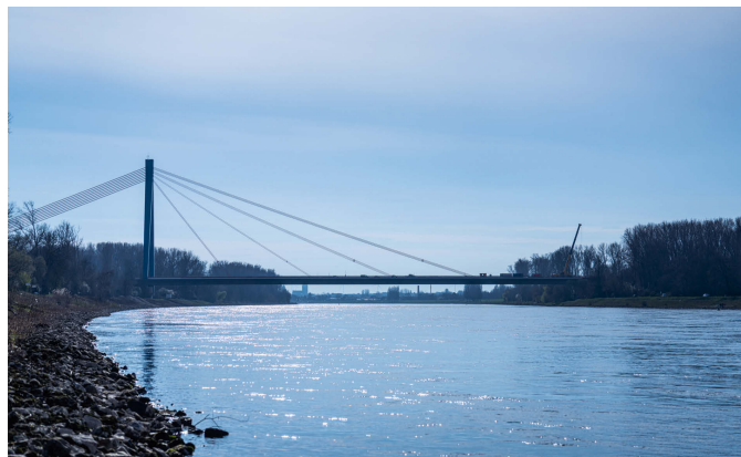
Bild 1 Rheinbrücke A61 bei Speyer. Zwischen der Schrägseilbrücke und der Vorlandbrücke rechts wurde die Fahrbahnübergangskonstruktionen (Üko) ausgetauscht.
