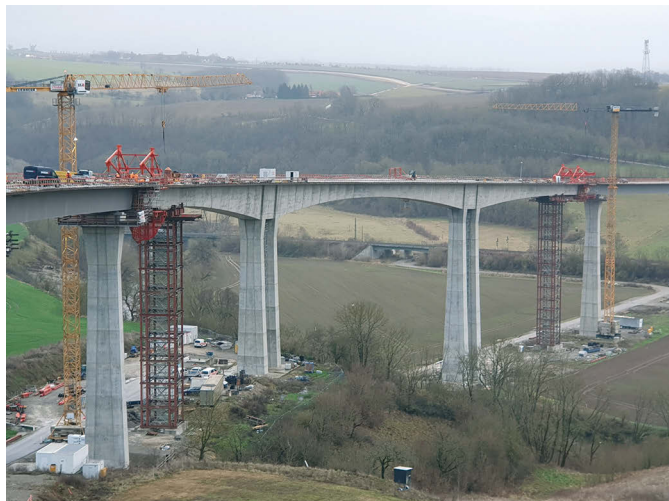
Bild 14 Freivorbau mit Hilfsstützen Cantilever erection with temporary supports
