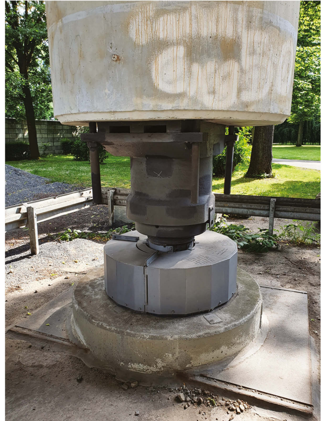
Bild 7 Stützenfuß der Stadtparkbrücke mit Ausgleichsvorrichtung für große Setzungen (Quelle: INGE A59) Pier base of the Stadtpark Bridge with compensation device for major settlements
