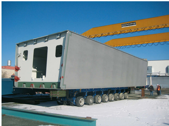
Bild 11 Stahlhohlkasten beim Transport Steel box girder at transport vehicles
