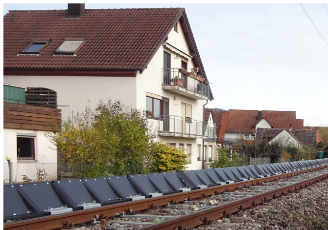
Bild 1 Die äußerst niedrigen Schallschutzelemente an der Bahnstrecke im Ammertal stören optisch kaum, fügen sich so optimal ins Landschaftsbild ein und sorgen für Ruhe im Wohngebiet.
