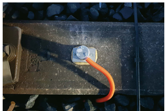
Bild 7 Foto eines montierten Schwellengeofons Photograph of a mounted sleeper geophone
