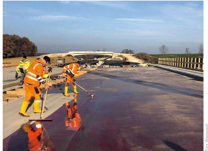
Bild 2 Die erste Lage der Versiegelung Wecryl 123 wurde per Gummischieber verteilt, mit der Fellrolle nachgewalzt und mit Quarzsand abgestreut.
