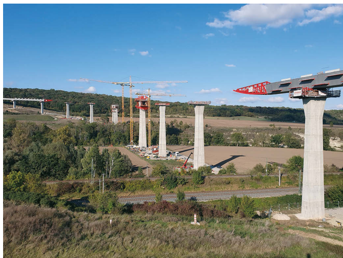
Bild 12 Einschub der Stahlhohlkästen Incremental launching of steel box girder
